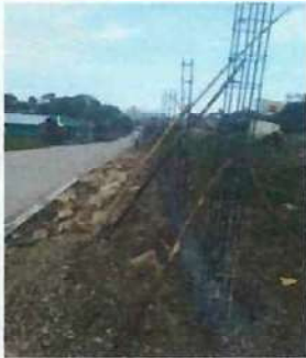
Foto 3: seguimiento al muro perimetral
