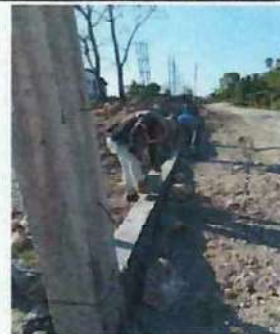
Foto 6: seguimiento de muro perimetral.
